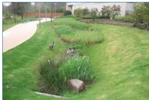
Vsakovací průleh. Zdroj: Sustainable Drainage Systems. Design Guide. Essex County Council. Chelmsford
